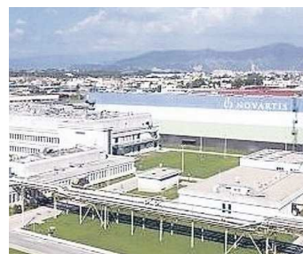
Gli impianti della Novartis a Torre Annunziata
