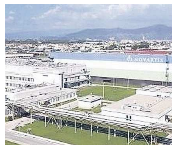
Gli impianti della Novartis a Torre Annunziata
