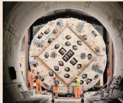
Grandi lavori. L'interno del cantiere per la linea Tav tra Torino e Lione
