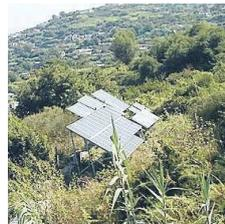
di 2,7 metri quadrati di estensione ognuno, ad un'altezza di circa 3 metri da terra, con inclinazione di 45 gradi. La superficie coperta dai moduli fotovoltaici misurerà complessivamente 42mila metri quadrati, ovvero per l'appunto come 6 campi da calcio regolamentari.
