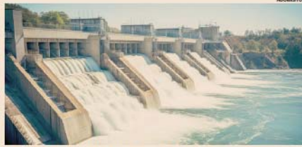
Concessioni idroelettriche. Bruxelles pretende il rispetto della concorrenza
